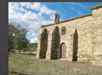
Ermita del Bendito Cristo de la Santa Cruz (Rabanal del Camino), empleo de cuarzitas de la Serie de los Cabos como material de construcción en sus muros y contrafuertes.
