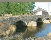
Puente romano de la Molinera, situado entre las localidades de San Justo de la Vega y Astorga. Construido con areniscas ordovícicas, a excepción de los arcos en los que se emplea pizarra. En las imágenes, se muestra una vista general y en detalle, en la que se aprecia la utilización de los dos materiales pétreos anteriormente mencionados.
